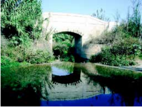
Fig. 2 Conocido como el Puente Romano del Riopudío
