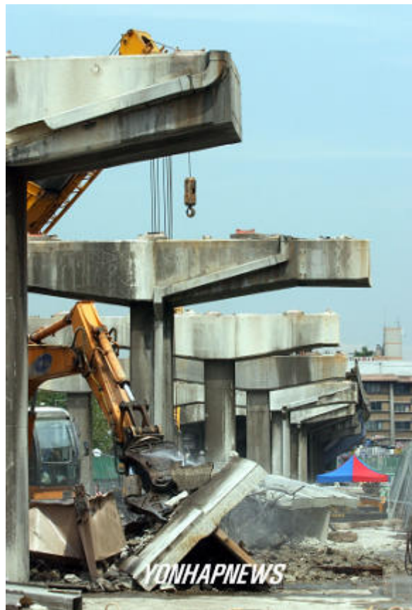
Demolición de la autopista elevada
