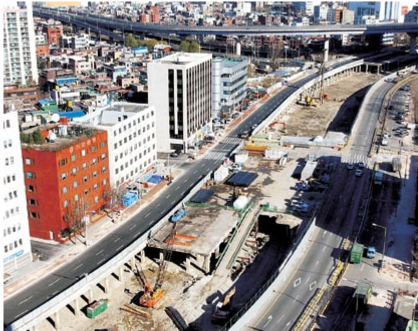
La demolición de la autopista comenzó en julio de 2003
