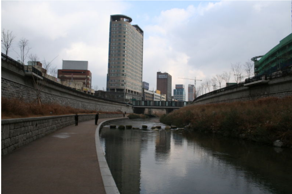
El proyecto de canal Cheonggyecheon presenta distintos tramos de espacio público
