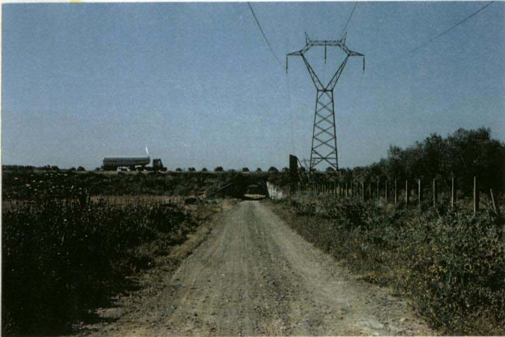
LA CAÑADA REAL A SU PASO BAJO LA A - 29
