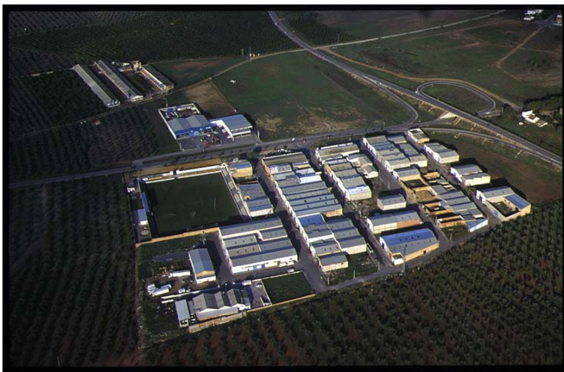
Polígono Industrial de los Ventolines en Pilas (1999)
