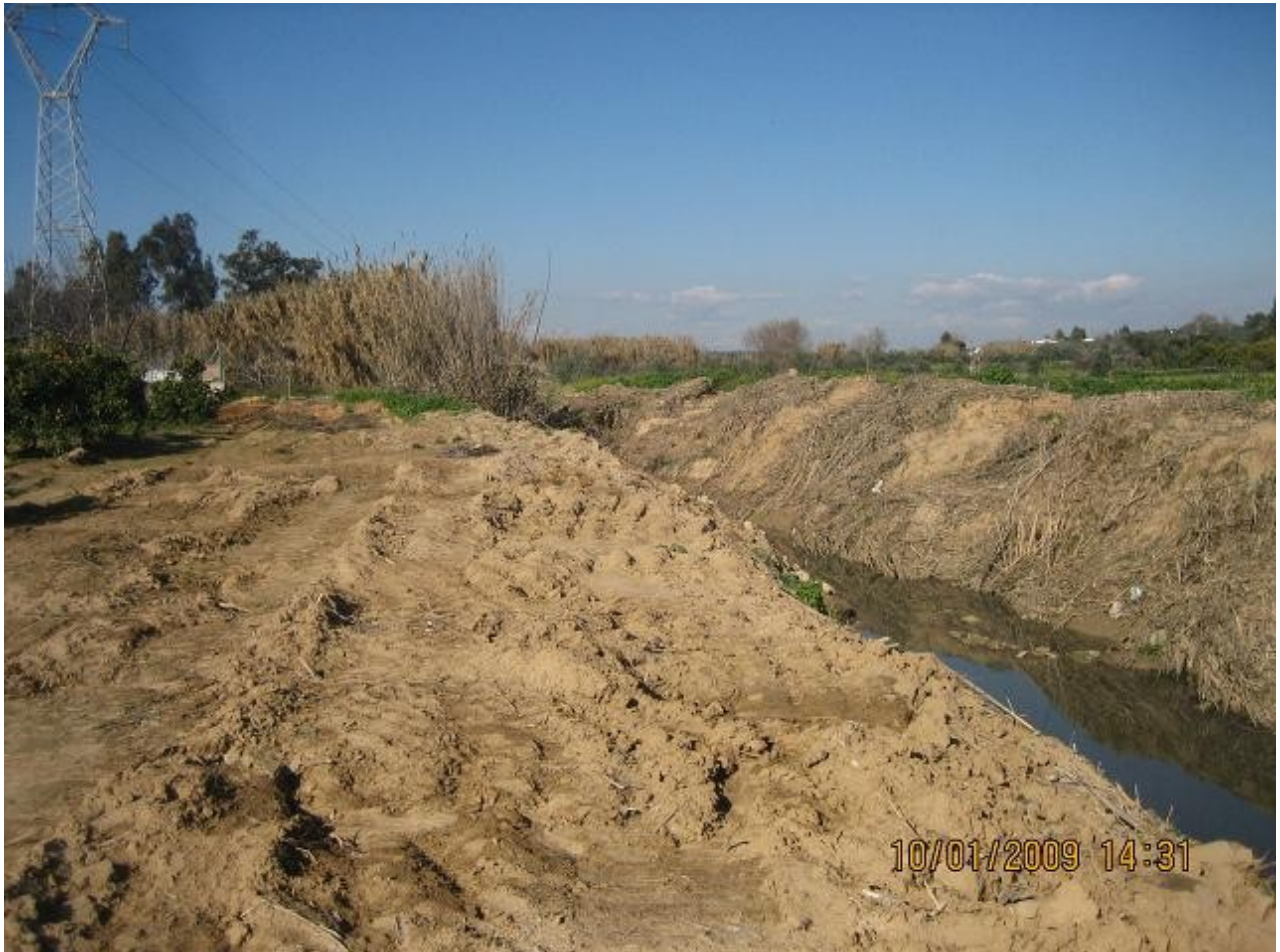
Las obras del Rio Pudio avanzan abriéndose camino trabajosamente...
