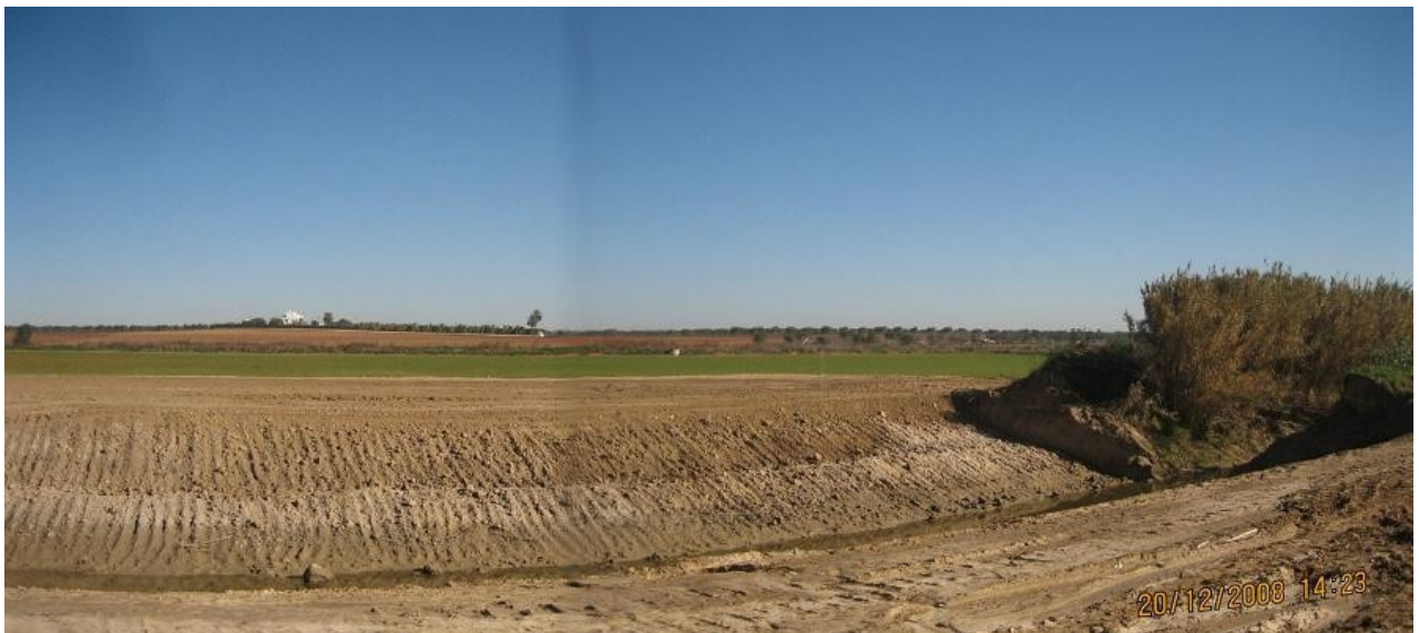
Las obras del Rio Pudio “descubren” un rio y un paisaje.
