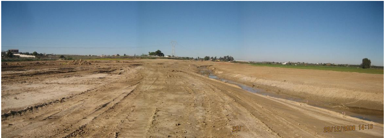
Las obras del Rio Pudio “descubren” un rio y un paisaje.
