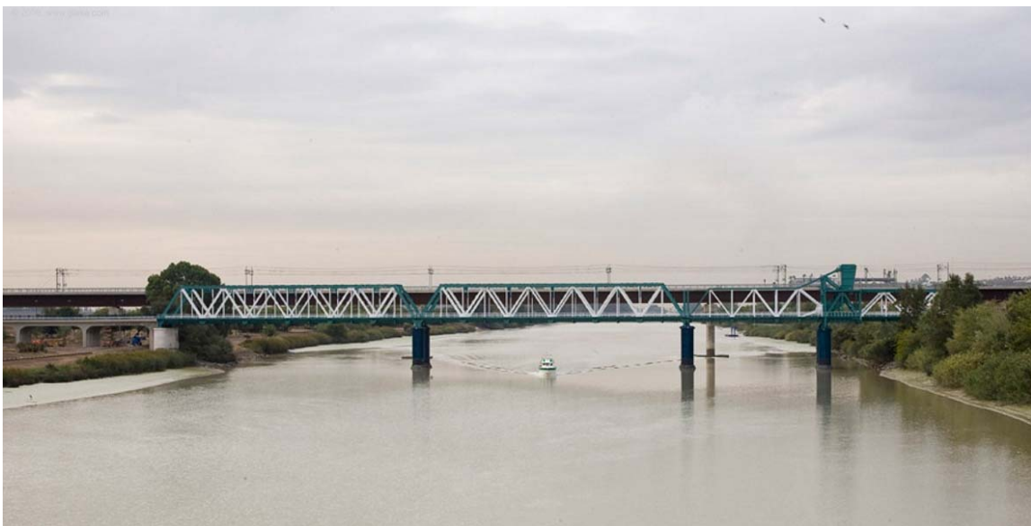
El puente metálico de San Juan de Aznalfarache salva el río Guadalquivir.
