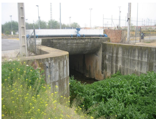
Comienzo del soterramiento
