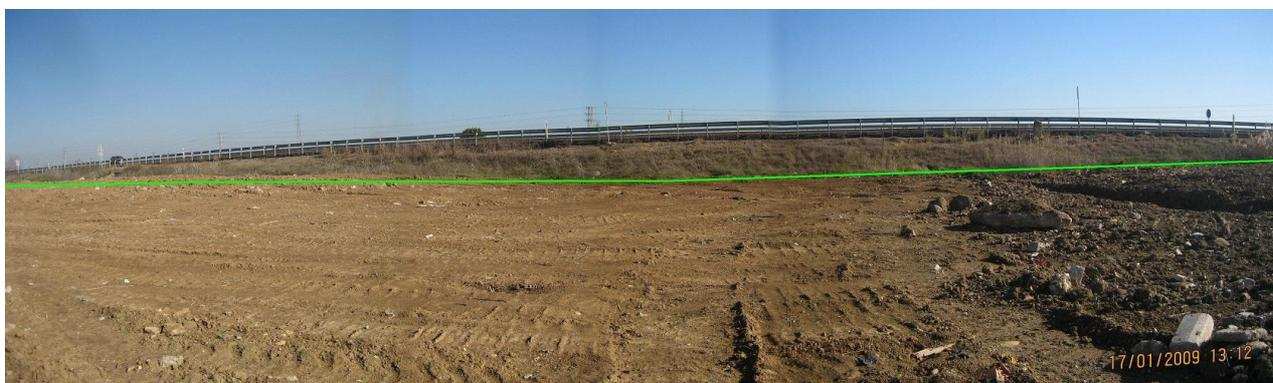
**Detalle del gran talud existente en el lateral de la carretera. Al fondo la cuneta de drenaje.**
