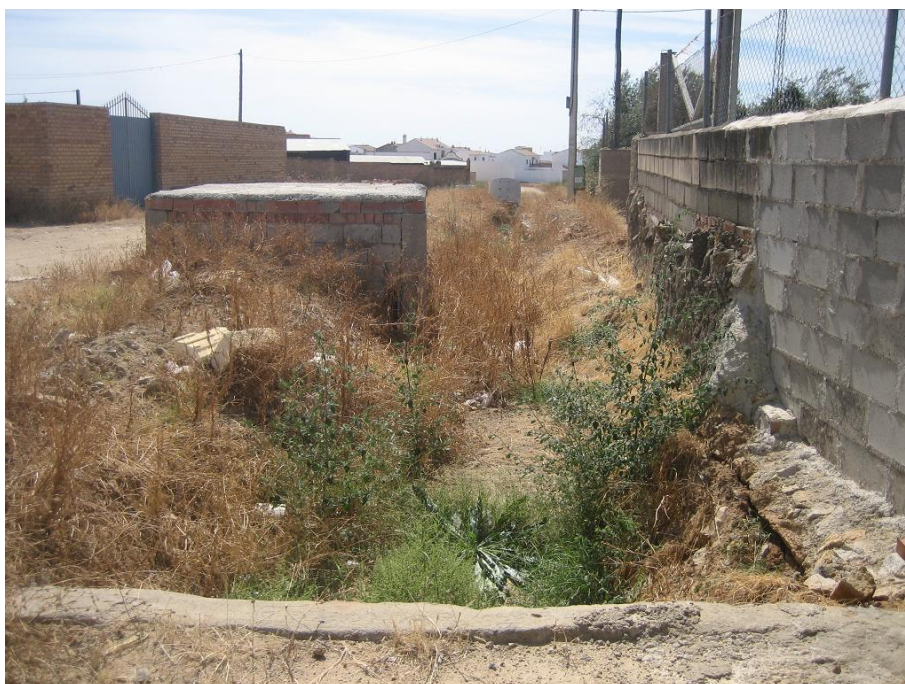
Foto 5. A unos metros del punto anterior el arroyo ocupado por un pozo de registro de la red de saneamiento.
