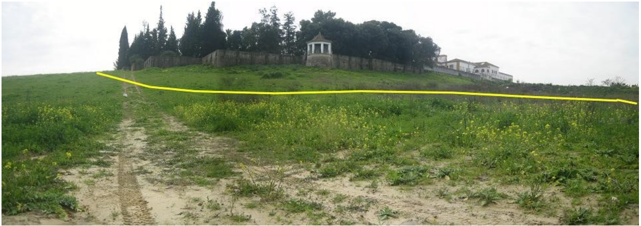
Fachada norte del BIC con el mirador mudéjar. En amarillo la línea aproximada, cuya urbanización propone el PGOU.
