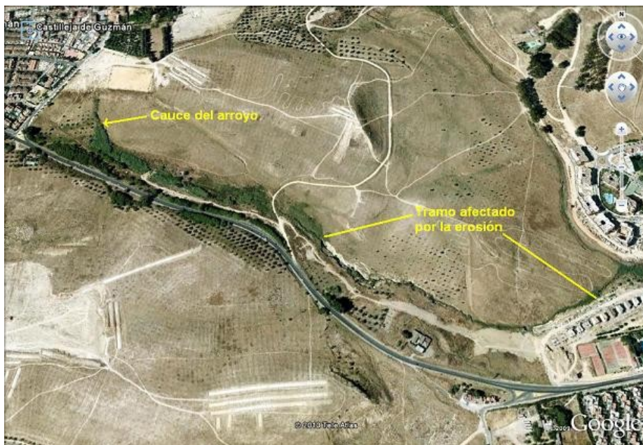
En la foto de Google se señala la zona del desplome del arroyo Alfileres. Podemos observar también el cauce del arroyo, que es distinto en su cabecera al señalado por el PGOU.
