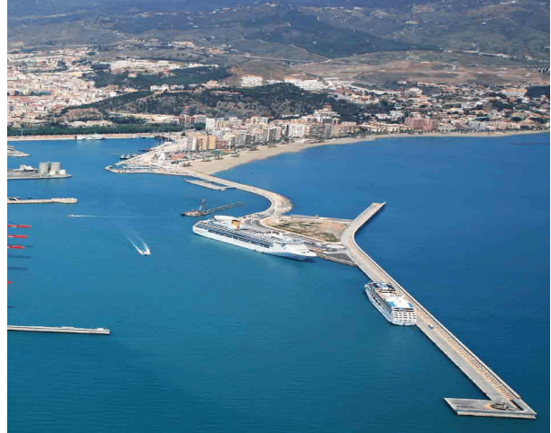
Fig.6. Obras de adecuación en el Puerto de Málaga
