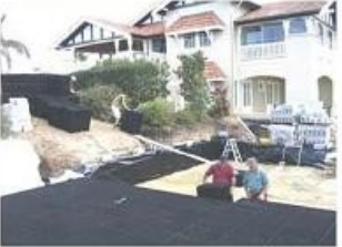
Depósitos de detención enterrados
