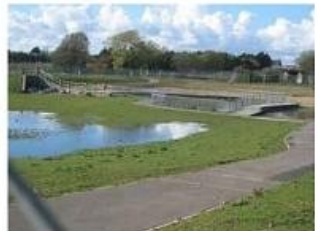
Depósitos de infiltración
