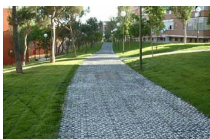
Figuras 2 a) y b). Aparcamiento permeable en Gijón y pavimento permeable en el Parque de Gomeznarro, en Madrid.
