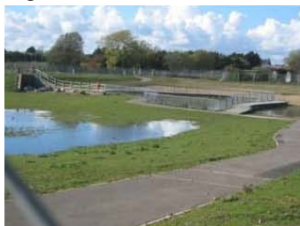
Figura 9. Depósitos de infiltración.
