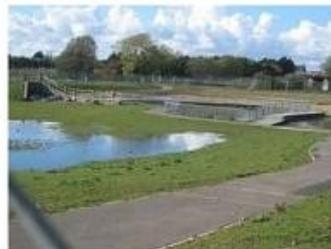
Depósitos de infiltración
