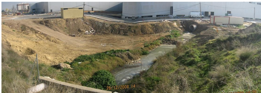
Arroyo La Fuentes soterrado y desviado detrás de MediaMarkt
