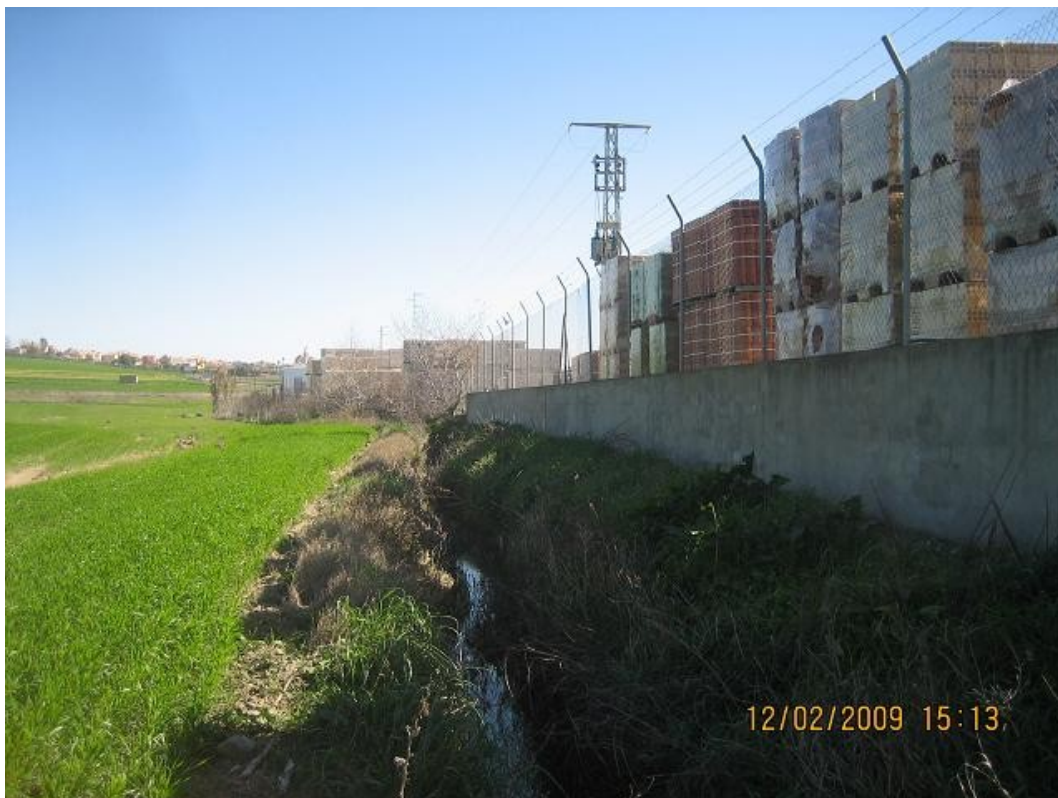
Polvero en la zona de servidumbre hidráulica
