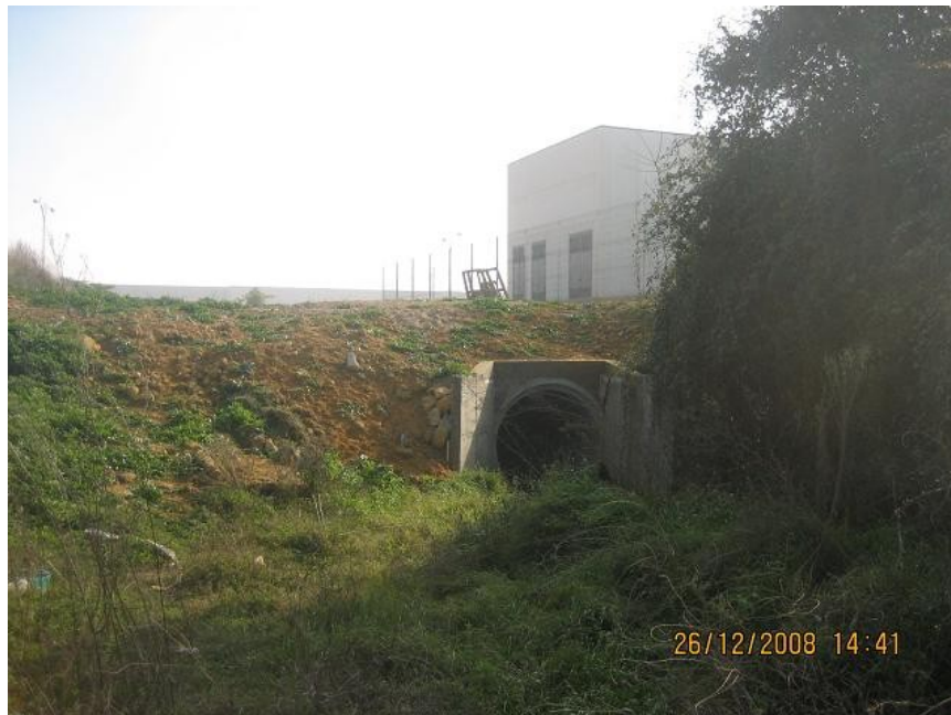
Soterramiento del arroyo Las Fuentes en Tomares junto subestación eléctrica
