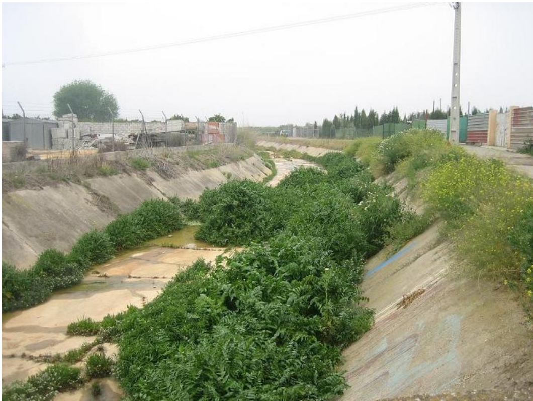
Tramo del arroyo Majalberraque, en Umbrete, propuesto para soterrar, al norte del tramo ya soterrado.
