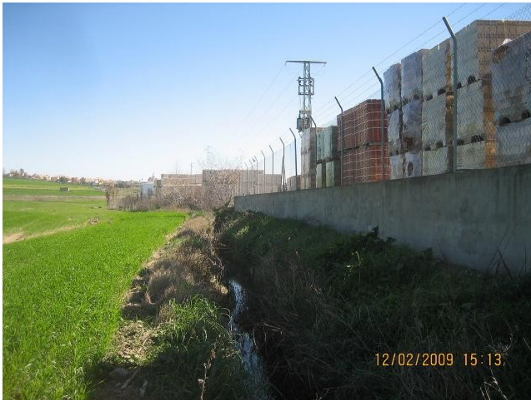
Polvero en la zona de servidumbre hidráulica
