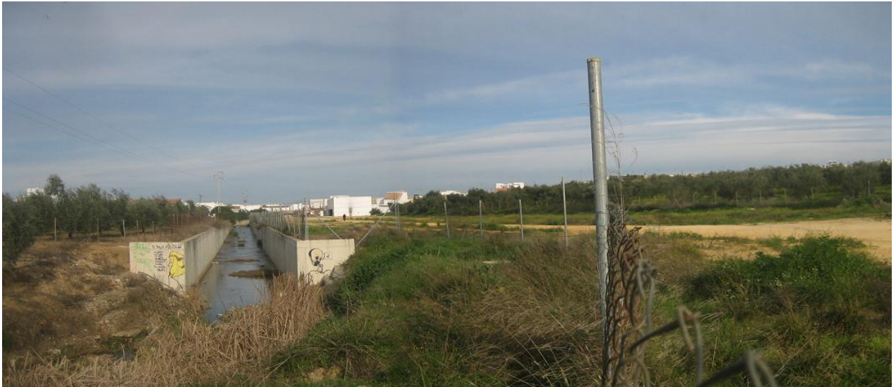
El arroyo Cañada Fria está soterrado bajo el casco urbano de Almensilla en su primer tramo. A la salida del casco urbano está canalizado, junto al campo de feria, en nuestra opinión, de forma innecesaria, que además agrava los efectos de la erosión.
