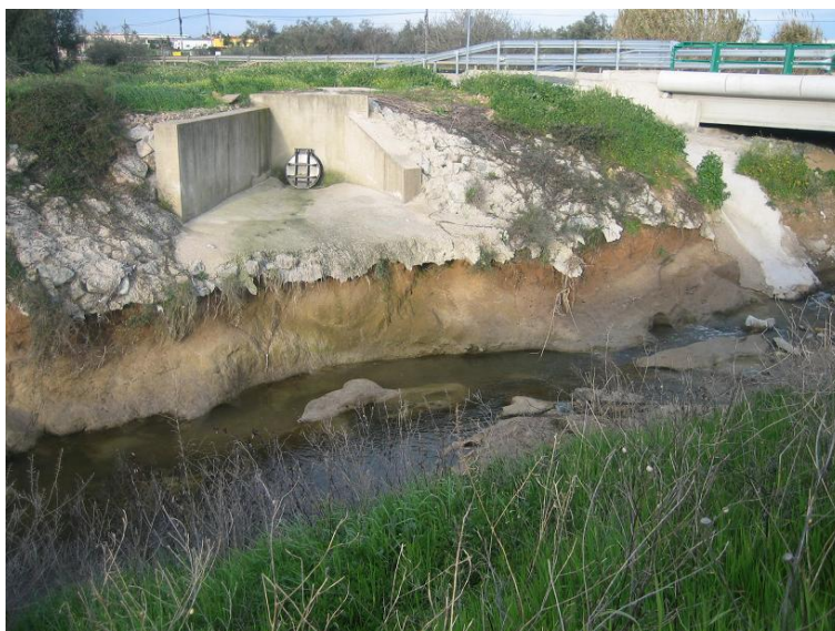
Uno de los emisarios de aguas pluviales en el Riopudío, en el término de Almensilla. Se puede observar la fuerte erosión provocada en el lecho del arroyo.
